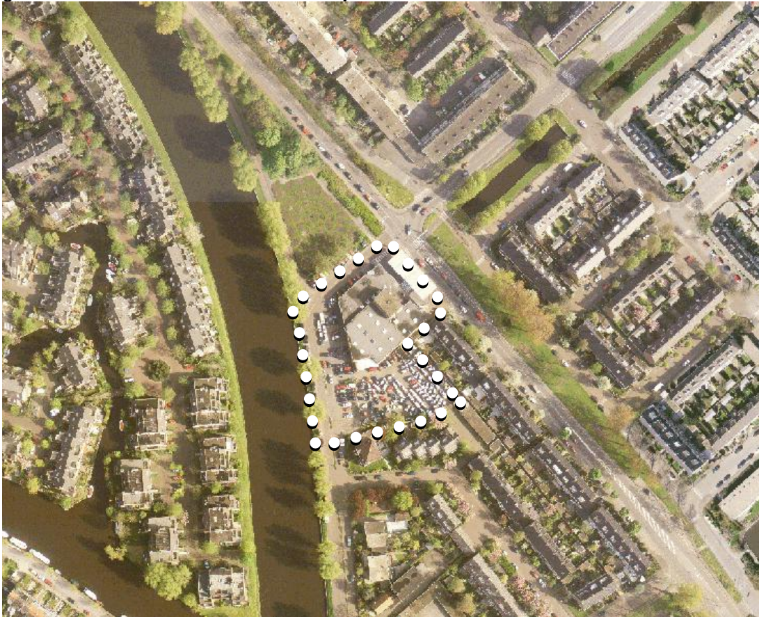
Figuur 1 - luchtfoto bestaande situatie
